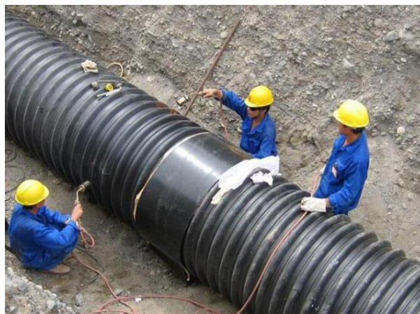
Рис. 1 – Монтаж ділянок каналізаційного колектору (полімерні труби «КОРСИС»)
