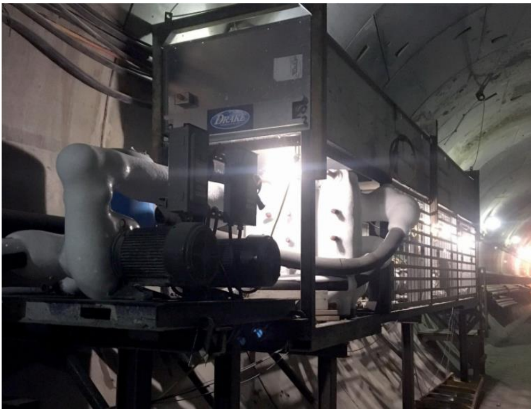
Рис. 2. Морозильна установка в межах тунелю
