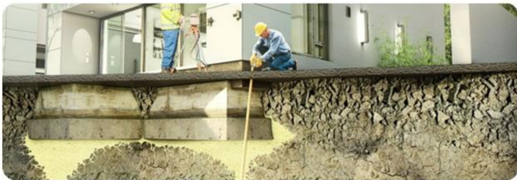
Рис 1. Використання технології «SLAB LIFTING»
