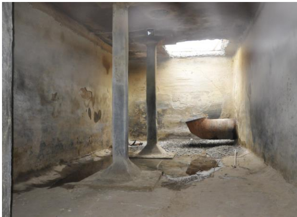
Рис.2. Залізобетонний резервуар води: а – до реконструкції, б – під час проведення реконструкції
