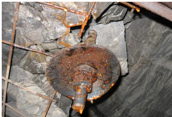
Рис. 1. Опускание анкерной крепи
