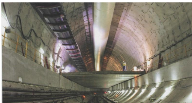
Рис. 4. Будівництво дворівневого тунелю
