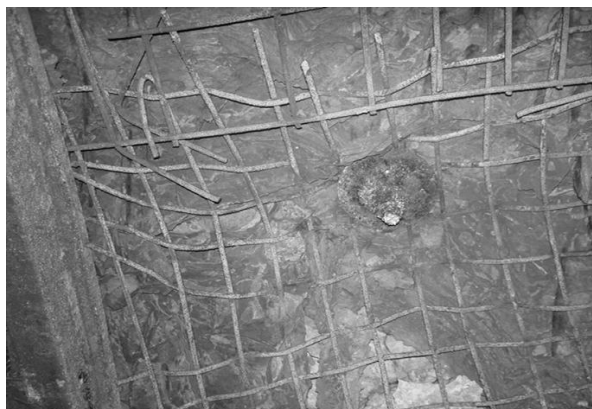
Рис. 2. «Обыгрывание» анкеров боковыми породами
