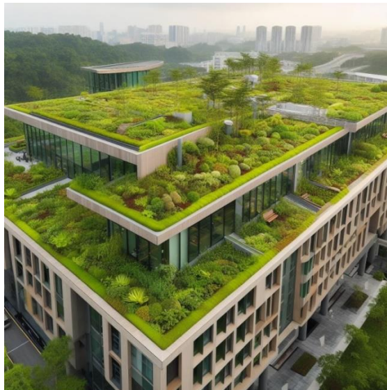
Рис. 5.9 - Зелений дах житлового будинку
