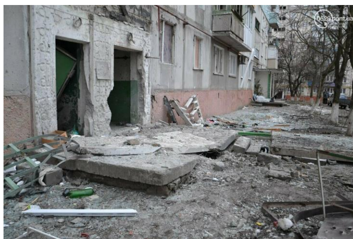
Рис. 4.3 - Зруйнований під'їзд житлового будинку
