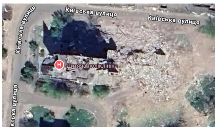
Рис. 4.4 - Аерознімок зруйнованої будівлі дитячої поліклініки
