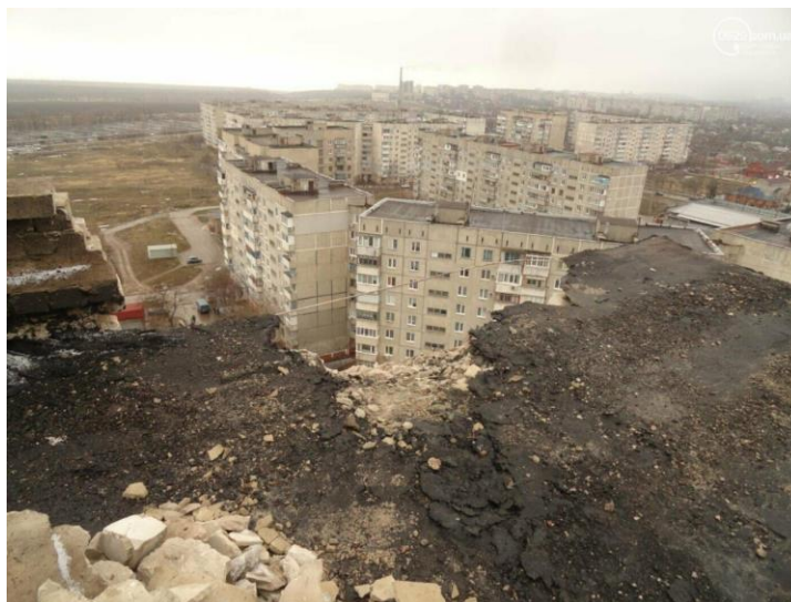
Рис. 4.2 - Зруйнований житловий будинок
