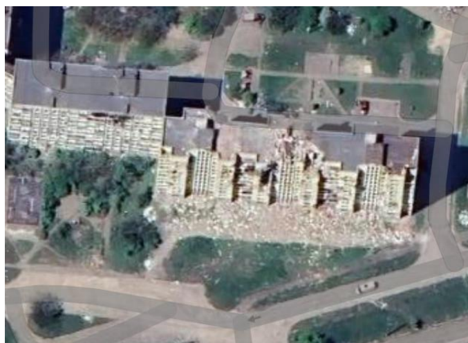
Рис. 5.1 - Зруйнований житловий будинок, що не підлягає відбудові (47.12210829681622, 37.69156467408332)
