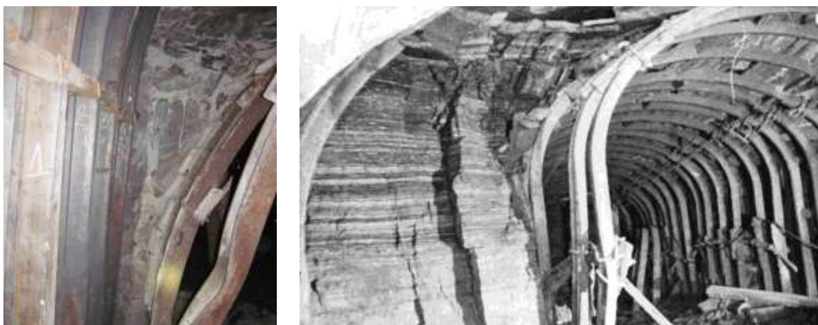
Рис. 1. Развитие зон трещиноватости в приконтурном массиве пород
