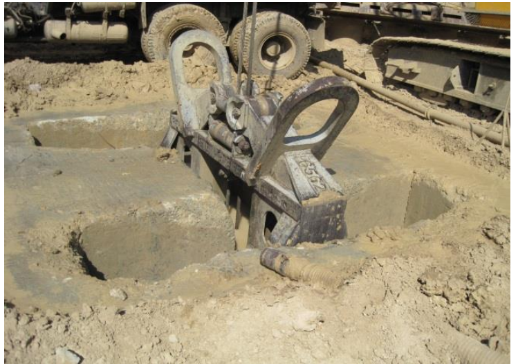
Рис. 2. Формування «барет» на будівельному майданчику
