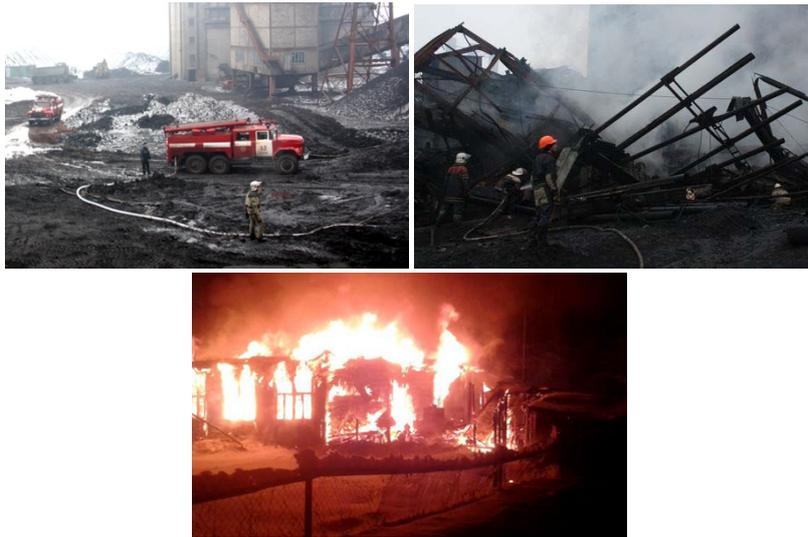
Рис. 1 – Последствия пожаров в шахтах из-за неисправности электросетей
