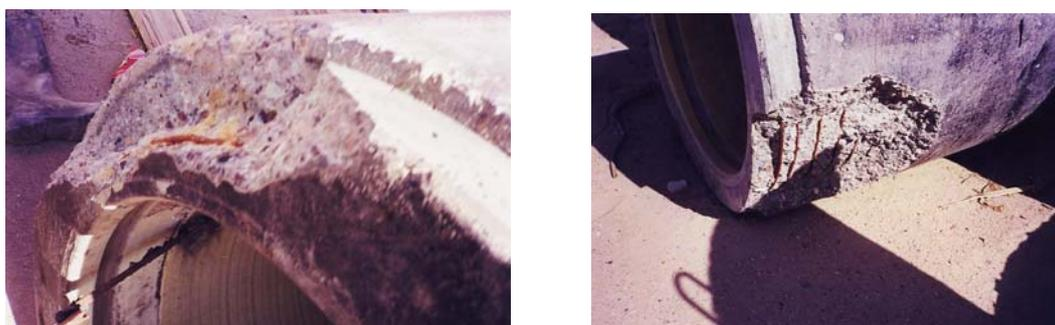
Рис. 2 –Разрушение торцевой части обделки в виде скола
