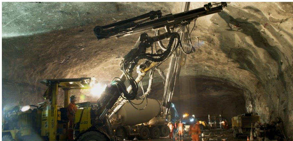
Рисунок 1 – Спорудження виробки суцільним вибоєм на повний переріз
