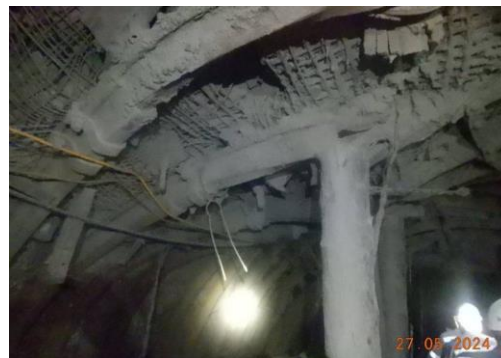
Рисунок 8 – Локальна деформація конвеєрного штреку на етапі підтримання за очисним вибоєм.
